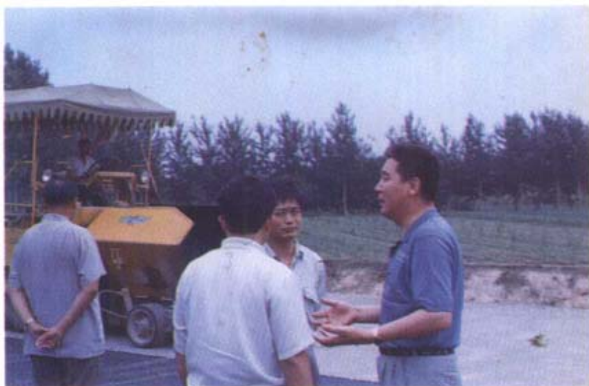
→ 王裕荣（右一）、范 正金（右二）在筑路 现场。
